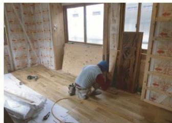
床板下地の合板の上に仕上げ床材
