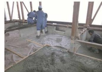
床下からの湿気対策のためにポリフィルム敷の上土間コンクリート打
