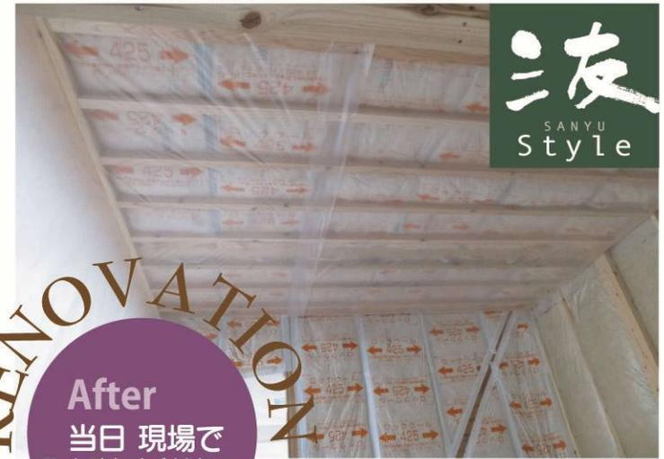
天井・壁に断熱材を丁寧に施工
