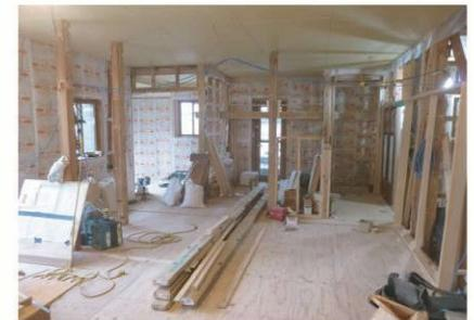
床下にも断熱材を施工して床板下地の合板を施工
